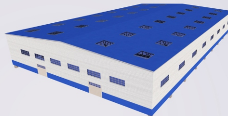
Обшивка сэндвич-панелей (готовое здание)
